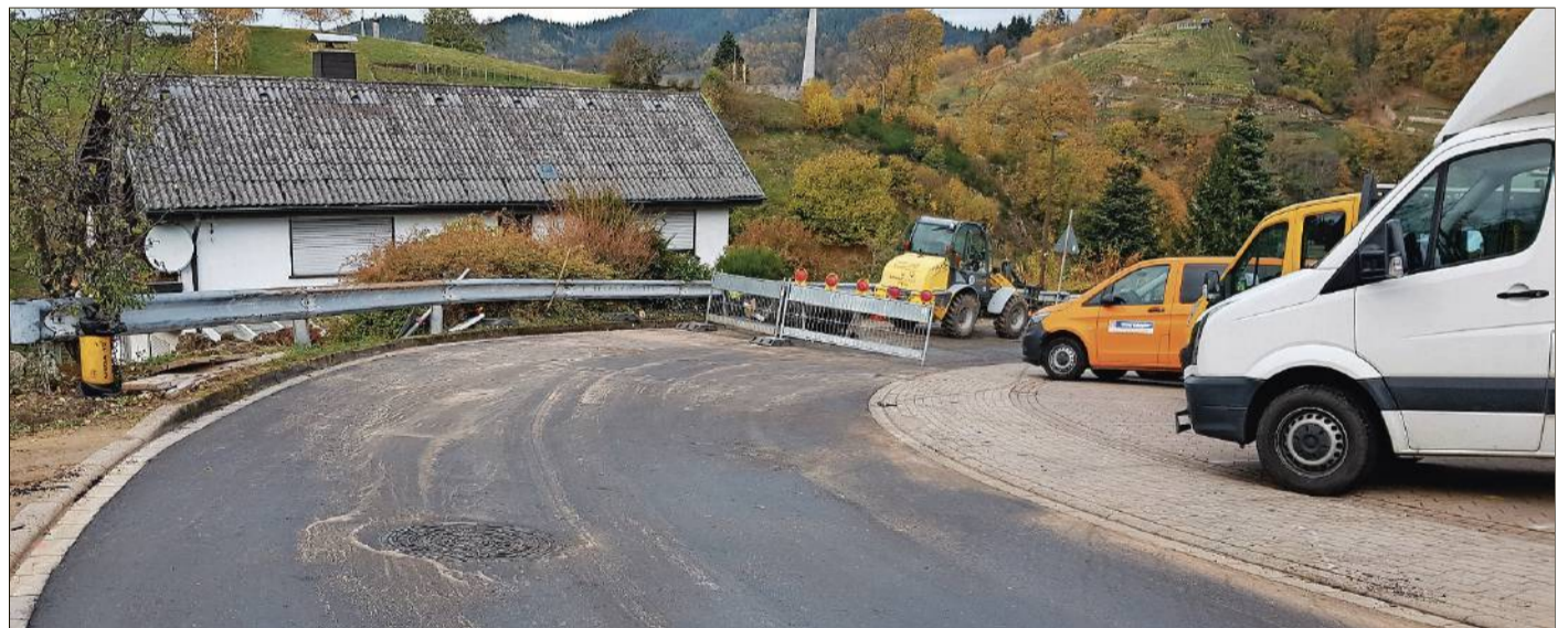
Neuer Verlauf: Die Wasserleitung im sanierten Teil der Haabergstraße liegt nun im öffentlichen Terrain. Foto: Gemeinde Bühlertal
